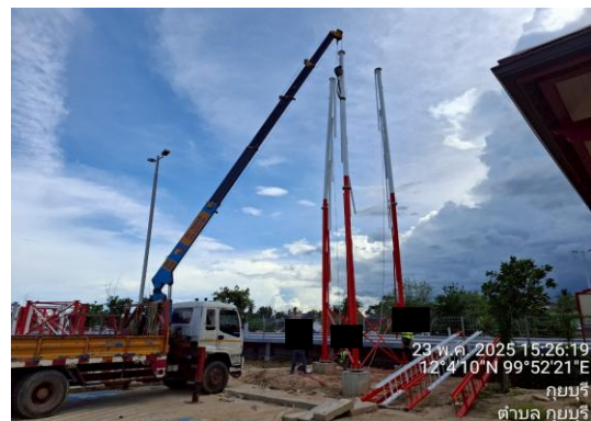
งานติดตั้งเสา Radio Tower
