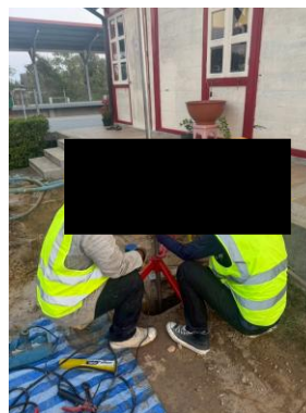
งานติดตั้งระบบกราวด์ของอุปกรณ์ในห้องรีเลย์ (Relay Room)
