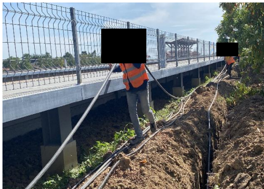
รูปที่ 1-3 งานขุดและติดตั้งเคเบิล (Cabling)
