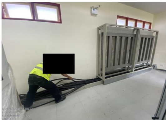
งานลากสายเคเบิล และติดตั้งอุปกรณ์ห้องรีเลย์ (Relay Room)
