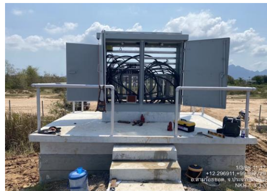
งานติดตั้งสายเคเบิลที่ตู้ LOC
