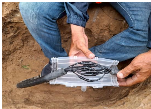
งาน Jointing สายเคเบิล
