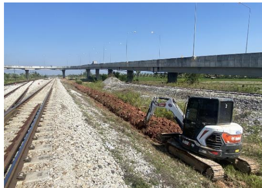
รูปที่ 1-3 งานขุดและติดตั้งเคเบิล (Cabling)
