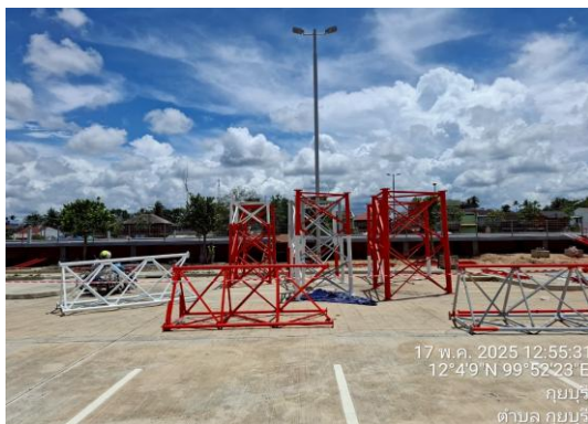
งานติดตั้งเสา Radio Tower
